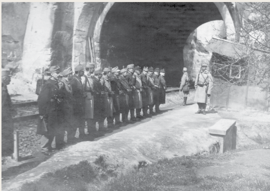
Stráž domobrany před tunelem v roce 1916.
